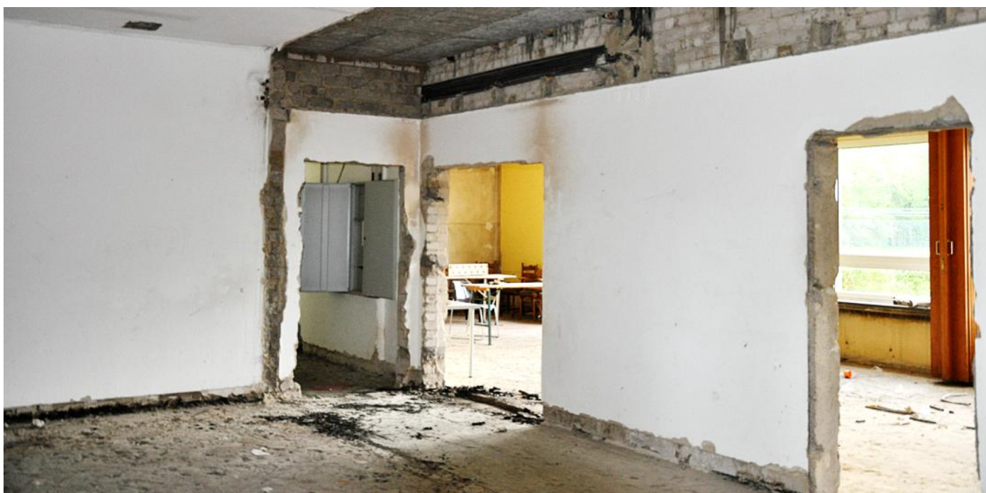
Die entkernten Räume im Obergeschoss (oben) und Erdgeschoss.
